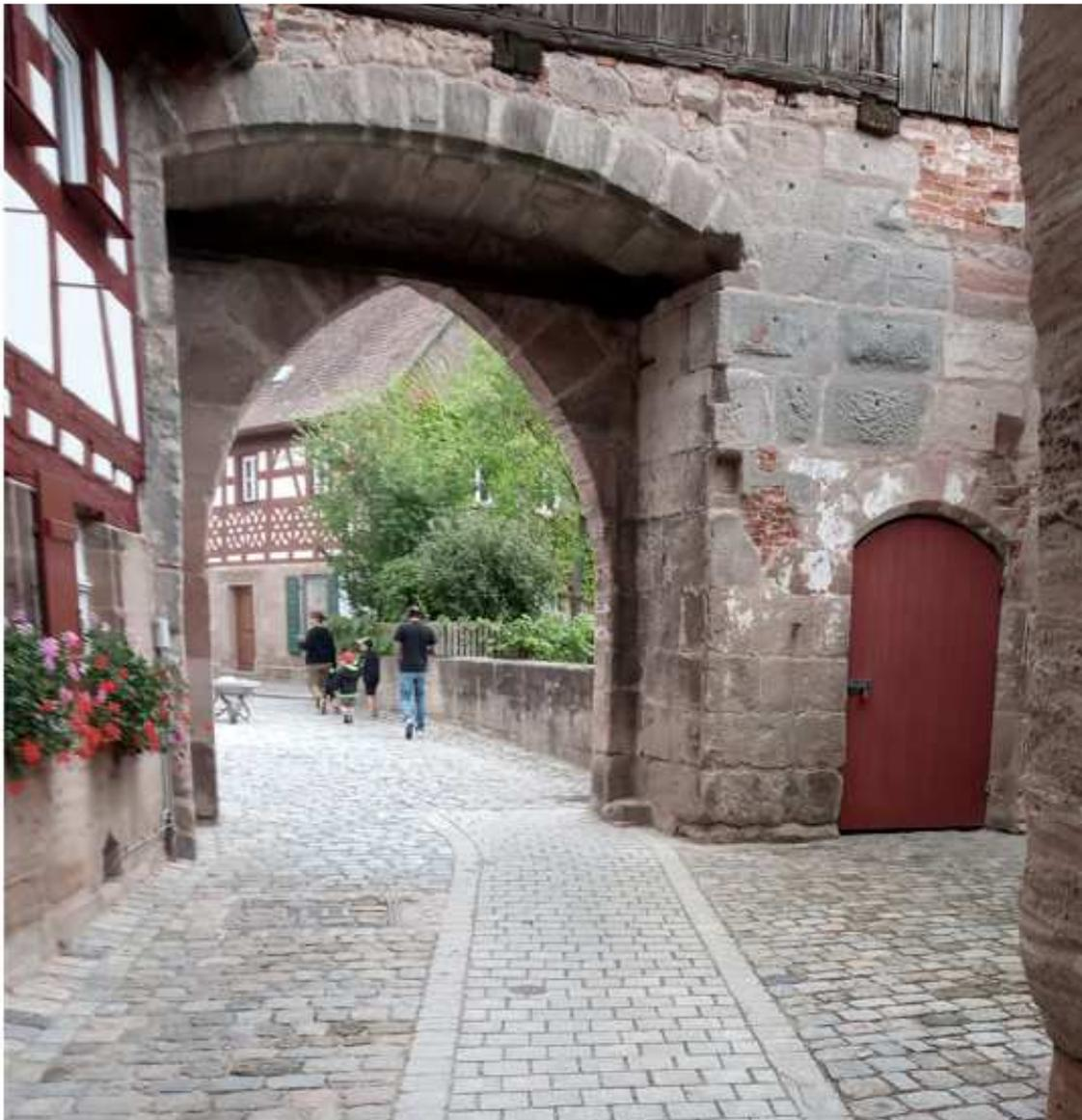
Bild 1: Blick vom Burghof Richtung Marktplatz. Hier wurde vorweg bereits ein kontrastreicher, barrierearmer Streifen in das historische Pflasterbild integriert, der als Vorlage für den weiteren Ausbau dienen soll.
