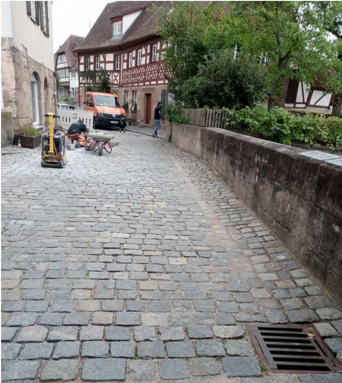
Bild 2: Unruhiges Granitgroßpflaster in Reihe im Burghof erfordern Trittsicherheit und erschweren das Begehen und Befahren beispielsweise mit Rollatoren und Rollstühlen.
