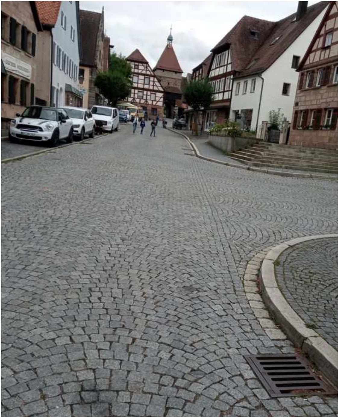
Bild 3: Granitkleinsteinpflaster in Segmentbögen verlegt.
